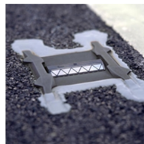
Слика 1: Обезбеђивање позитивног вођења - а) б) табле за усмеравање в) издигнути маркери у коловозу
