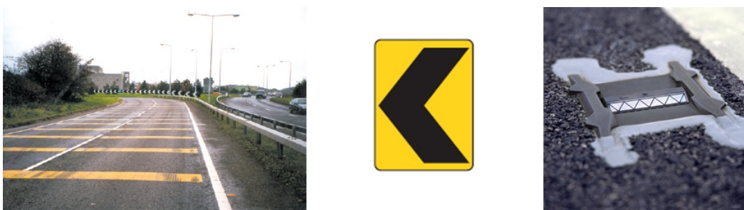
Слика 1: Обезбеђивање позитивног вођења - а) б) табле за усмеравање в) издигнути маркери у коловозу
