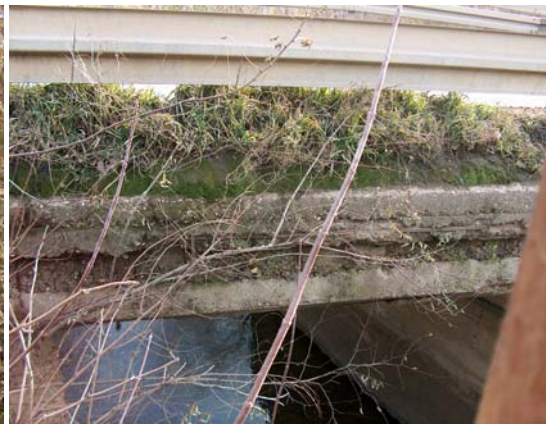
Ивица плоче – види се висина дограђеног асфалта
