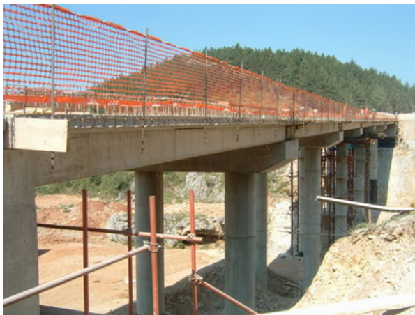
Слика 8. Поглед на мост 7 у изградњи
