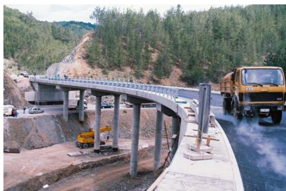
Слика 7. Поглед одозго на мосту бр.1
