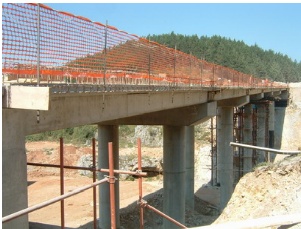
Слика 8. Поглед на мост 7 у изградњи
