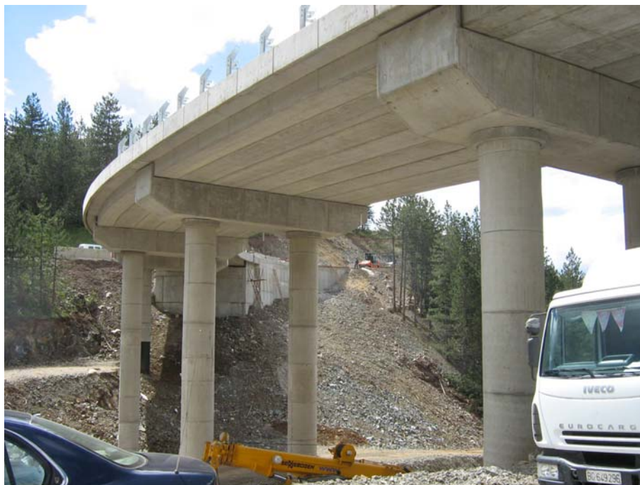
Слика 3. Поглед одоздо на мост бр.1
