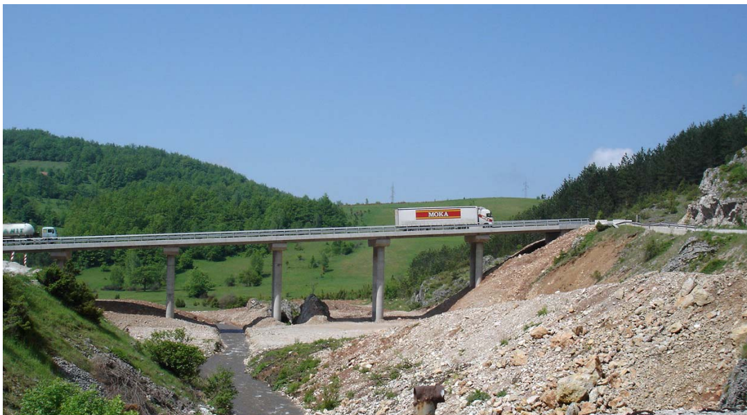
Слика 13. Мост 7 под саобраћајем
