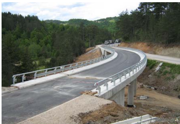
Слика 6. Поглед одозго на мосту бр.5
