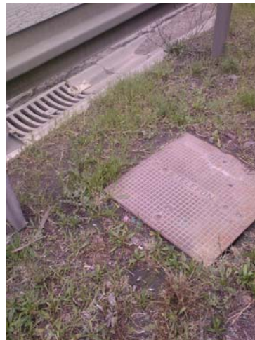
Слика 3 и 4 : Шахт кишне канализације у непосредној близини „Сава центра“ у који се уселио ПТТ
