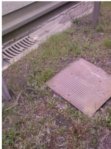
Слика 3 и 4 : Шахт кишне канализације у непосредној близини „Сава центра“ у који се уселио ПТТ
