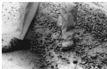
Слика 7: Пример ниског нивоа губитка агрегата
