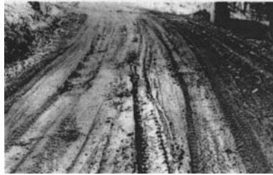
Слика 1: Пример попречног профила високог нивоа оштећености
