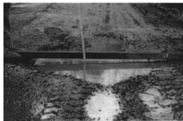
Слика 5: Пример рупа високог нивоа оштећености
