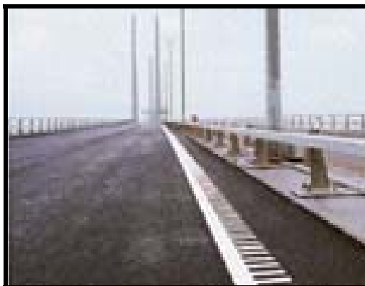
Слика 2: Примена термопластичних материјала на коловозној конструкцији
