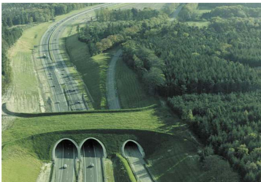
Слика 2. Пројекат пута у складу са заштитом животиња Figure 2. Road design with accent on wildlife protection
