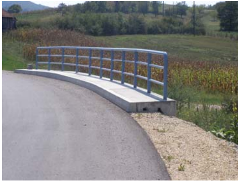
Slika 3: Novi objekti bez zaštitnih ograda i sa neadekvatnim rešenjem ugradnje
