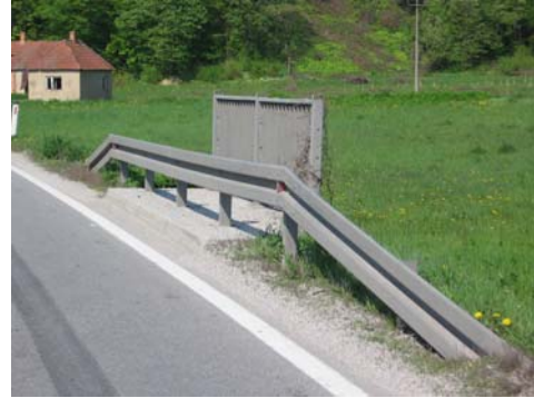
Slika 3: Novi objekti bez zaštitnih ograda i sa neadekvatnim rešenjem ugradnje
