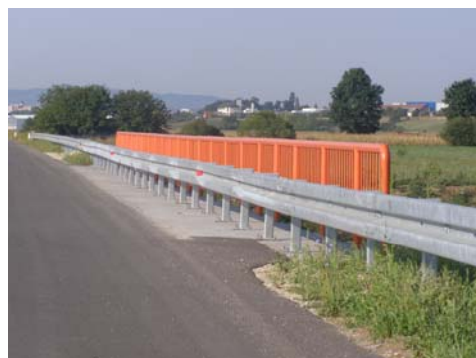
Slika 2: Primeri različitih načina ugradnje zaštitnih čeličnih ograda na mostovima
